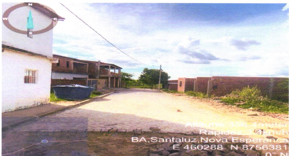
Execução de pavimentação Rua 04 Deloda
