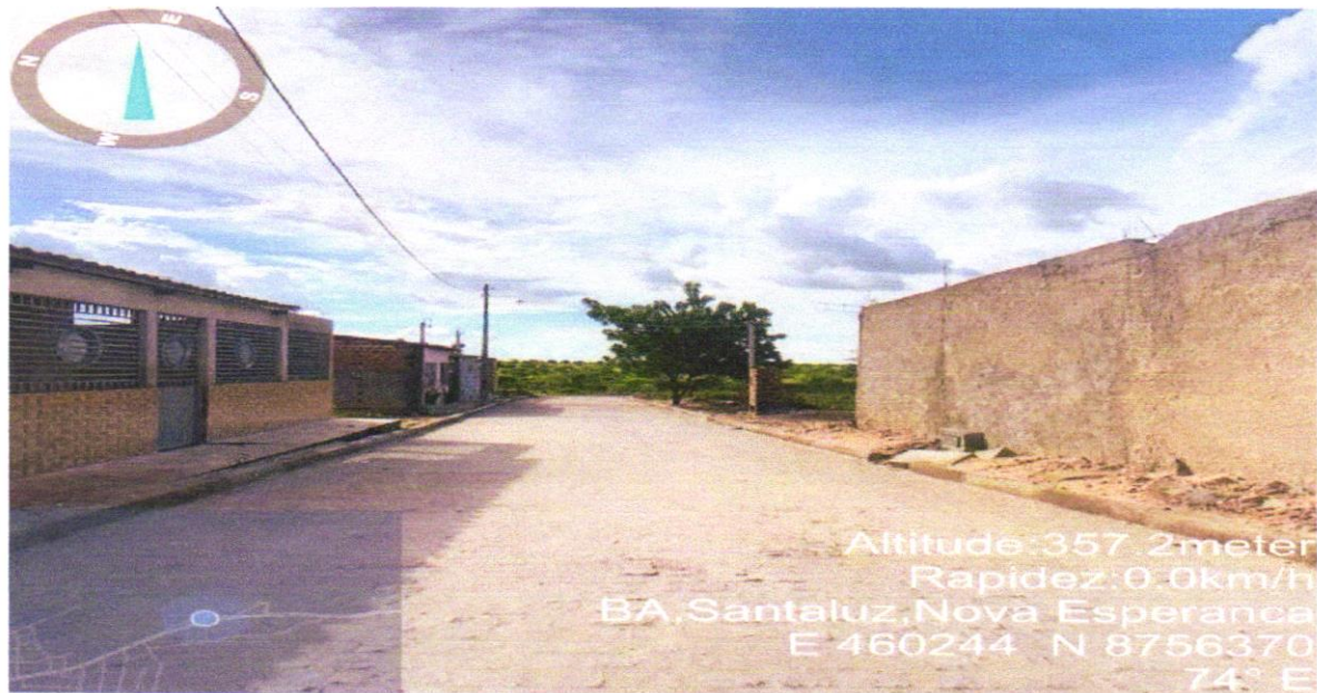
Execução de pavimentação Rua 03 Deloda
